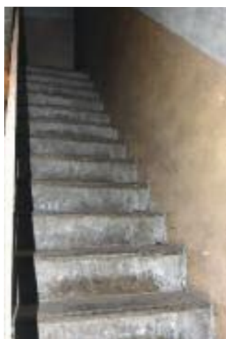
Escaliers - Atelier Gare
