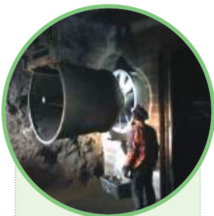
Mise en place du ventilateur principal
