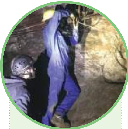
Installation d'une ligne de 1200 mètres de câble téléphonique. La mine pourra joindre n'importe quel numéro à partir du fond ! Essentielle pour la sécurité, cette phase est également nécessaire à la création du musée.
