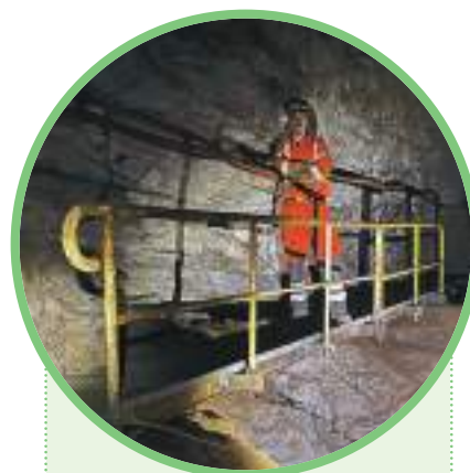
Création d'une passerelle au dessus d'un vide pour la galerie d'évacuation
